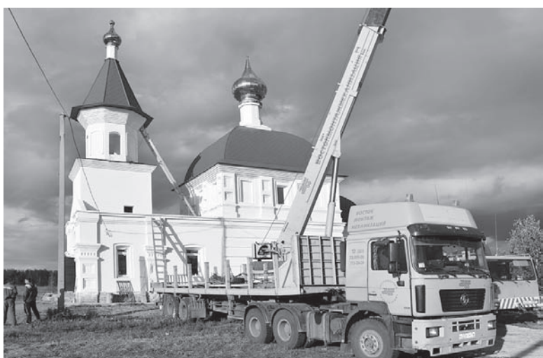
Октябрь 2016 года. Установка кровли и куполов.
